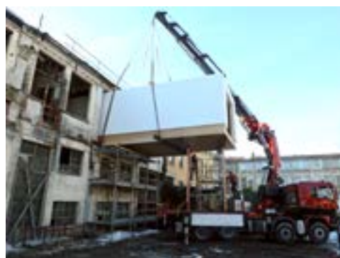
TRASPORTO E INSTALLAZIONE DEL PRIMO MODULO CASAZERA ALL'INTERNO DELL'EX FABBRICA NEBIOLO DI TORINO
