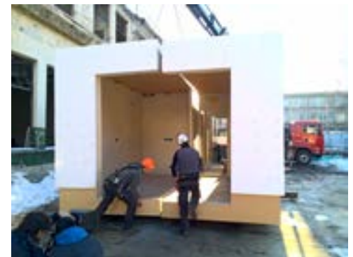
TRASPORTO E INSTALLAZIONE DEL PRIMO MODULO CASAZERA ALL'INTERNO DELL'EX FABBRICA NEBIOLO DI TORINO
