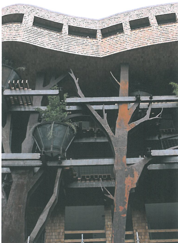
Particolare dei pilastri in cor-ten a forma di albero
